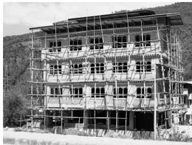
図9 ブータンの伝統的な建築物建設中
